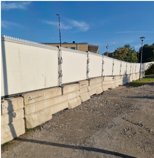
Figur 1, Det bullerdämpande byggstaketet
