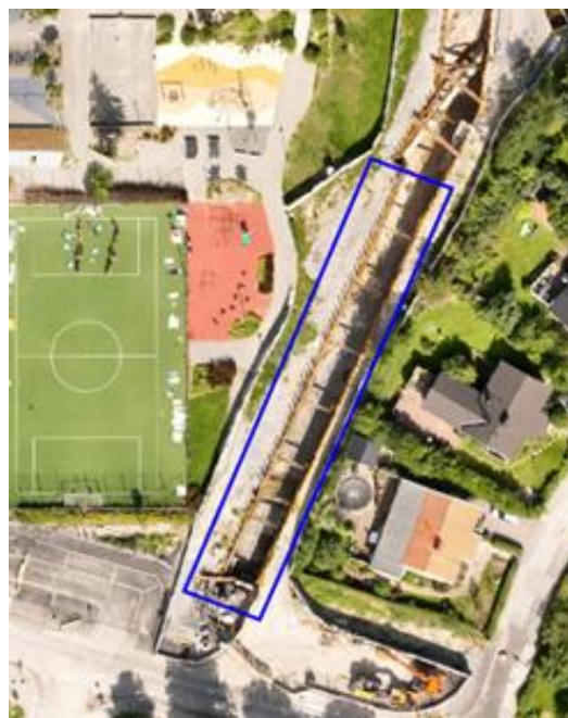
Bild 3: installation av ledningar
