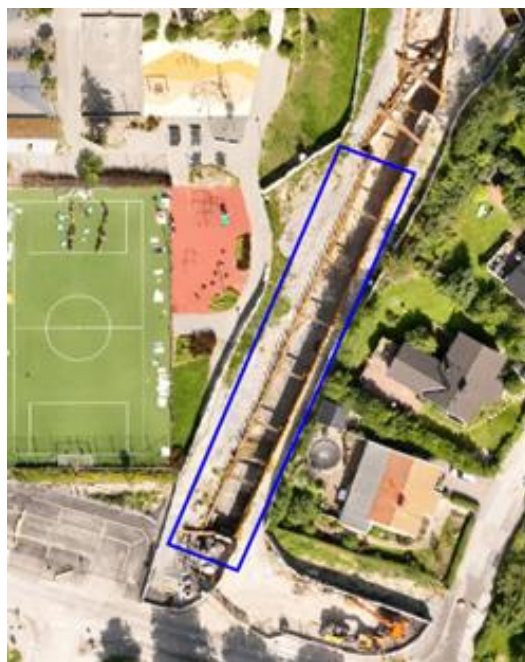
Bild 3: installation av ledningar
