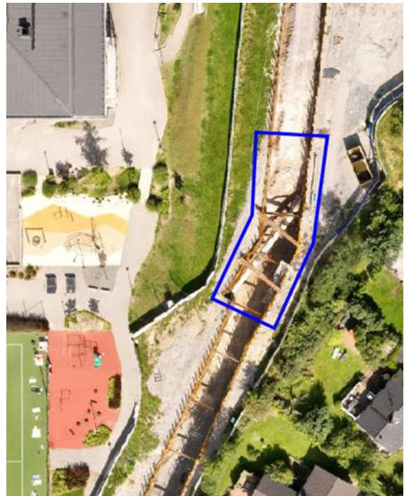
Bild 2: Installation av ledningar
