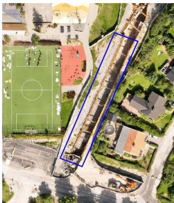
Bild 3: installation av ledningar
