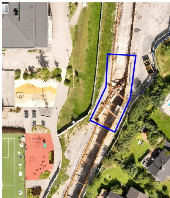
Bild 3: Installation av ledningar
