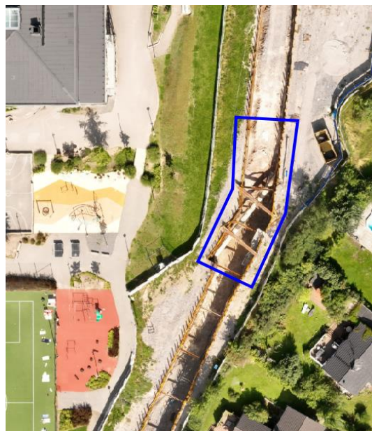
Bild 2: Installation av ledningar
